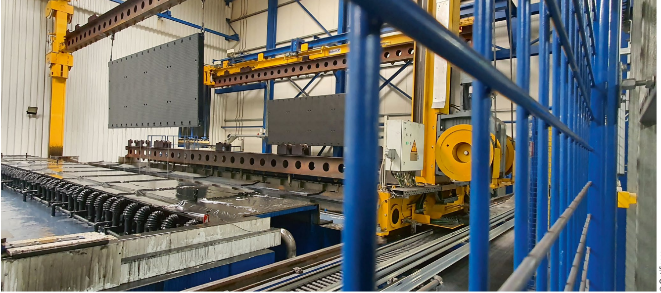
Die Lkw-Wechselbrücken erhalten an Warenträgern hängend eine KTL-Beschichtung.
